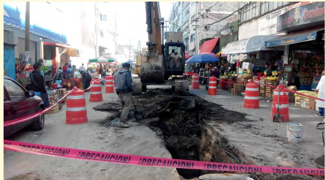
Meta: instalación de 3,279 m. de tubería de polietileno de alta densidad, corrugado.
