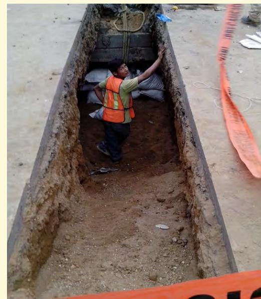
Meta: instalación de 48 m. de tubería de polietileno de alta densidad, corrugado.
