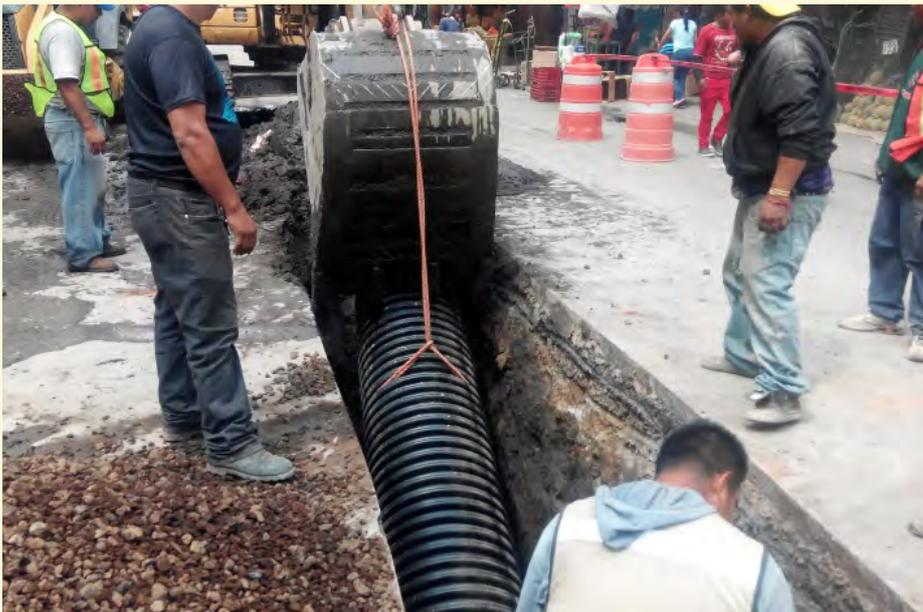
Meta: instalación de 112 m. de tubería de polietileno de alta densidad, corrugado.
