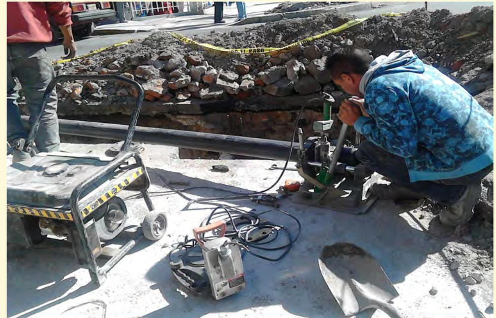
Meta: instalación de 480 m. de tubería de polietileno de alta densidad.
