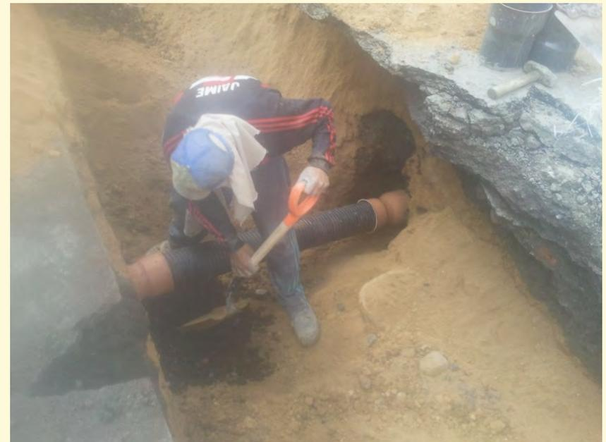
Meta: instalación de 261 m. de tubería de polietileno de alta densidad, corrugado.
